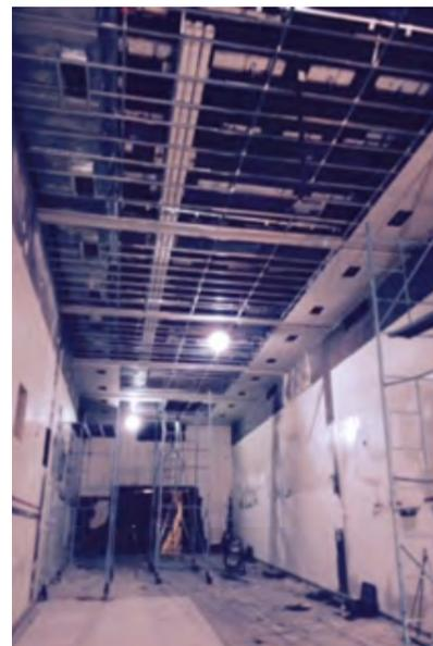
El microcine en obra. Instalación de ventilación reubicada sobre el cielorraso
